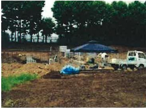
写真 7 : 現場に設置したテント
